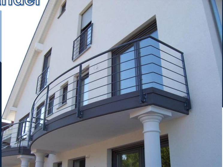
**MADE IN GERMANY** - Unsere Geländer werden aus Stahl gefertigt, für den Außenbereich werden diese feuerverzinkt nach DIN EN 1461 und optional pulverbeschichtet nach RAL-Farbkarte.
