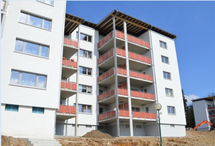
Dieses Geländer ist aus Stahl S235JR gefertigt , mit blickdichter Geländerfüllung.
