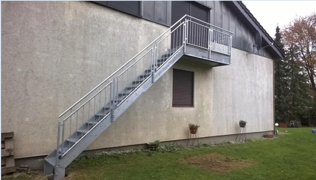
Dieses Geländer ist ein aus Stahl S235JR gefertigtes Geländer, es überzeugt durch die abgerundete Bauweise.
