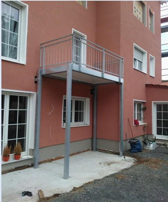
Dieses Geländer ist ein aus Stahl S235JR gefertigtes Geländer, es überzeugt durch die einfache Bauweise.
