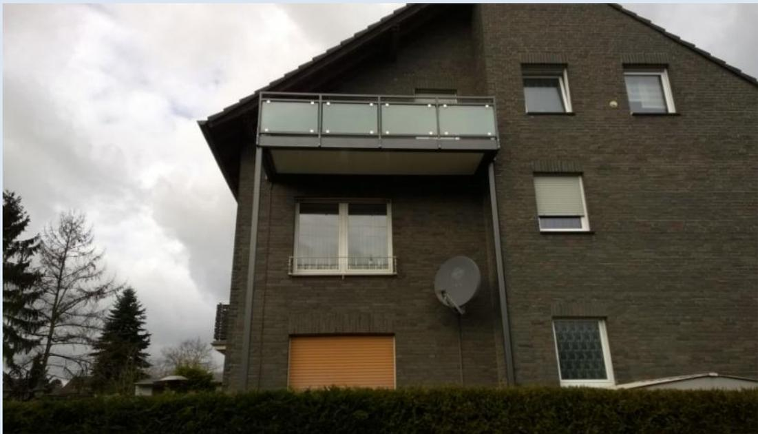
Dieses Geländer ist ein aus Stahl S235JR gefertigtes Geländer, es überzeugt durch seine kompakte Bauweise.
