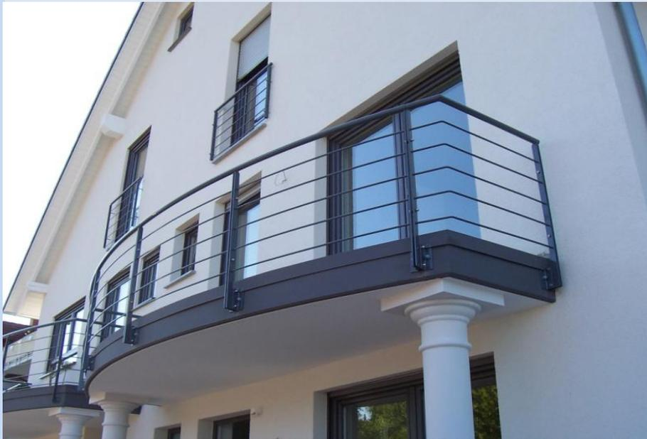
Dieses Geländer ist ein aus Stahl S235JR gefertigtes Geländer, es überzeugt durch die ansprechende Bauweise.
